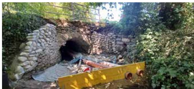
Photos pendant travaux
