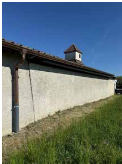
Travaux de toiture et charpente: réfection du chéneau et de la plate-bande nord-est
