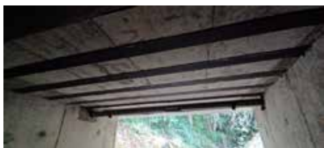
Photos après travaux: lamelles en carbonées, traitement de la carbonatation et béton lavé à haute pression
