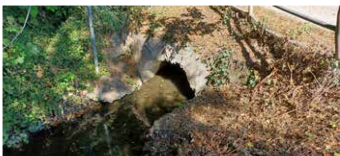
Photos après travaux
