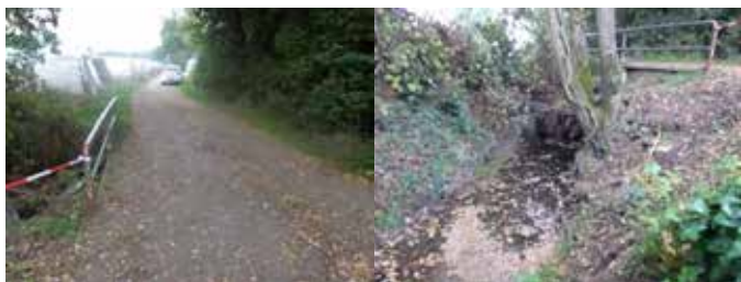
Photos avant travaux
