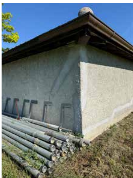
Travaux de maçonnerie en sous-œuvre: Renforcement de la sous-structure enterrée côté sud et scellement des fissures existantes
