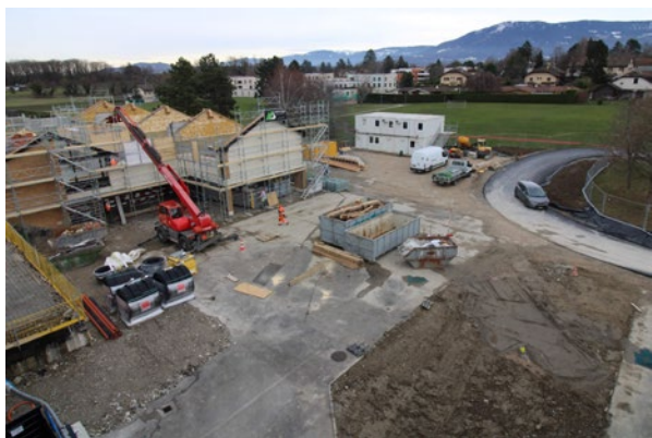
Travaux d'assainissement et de démolition
