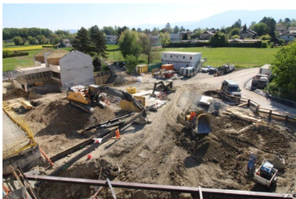
Travaux de terrassement
